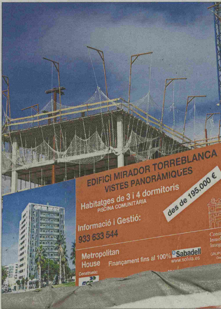
Viviendas en construcción, en Sant Feliu de Llobregat (Barcelona). / M. M.
